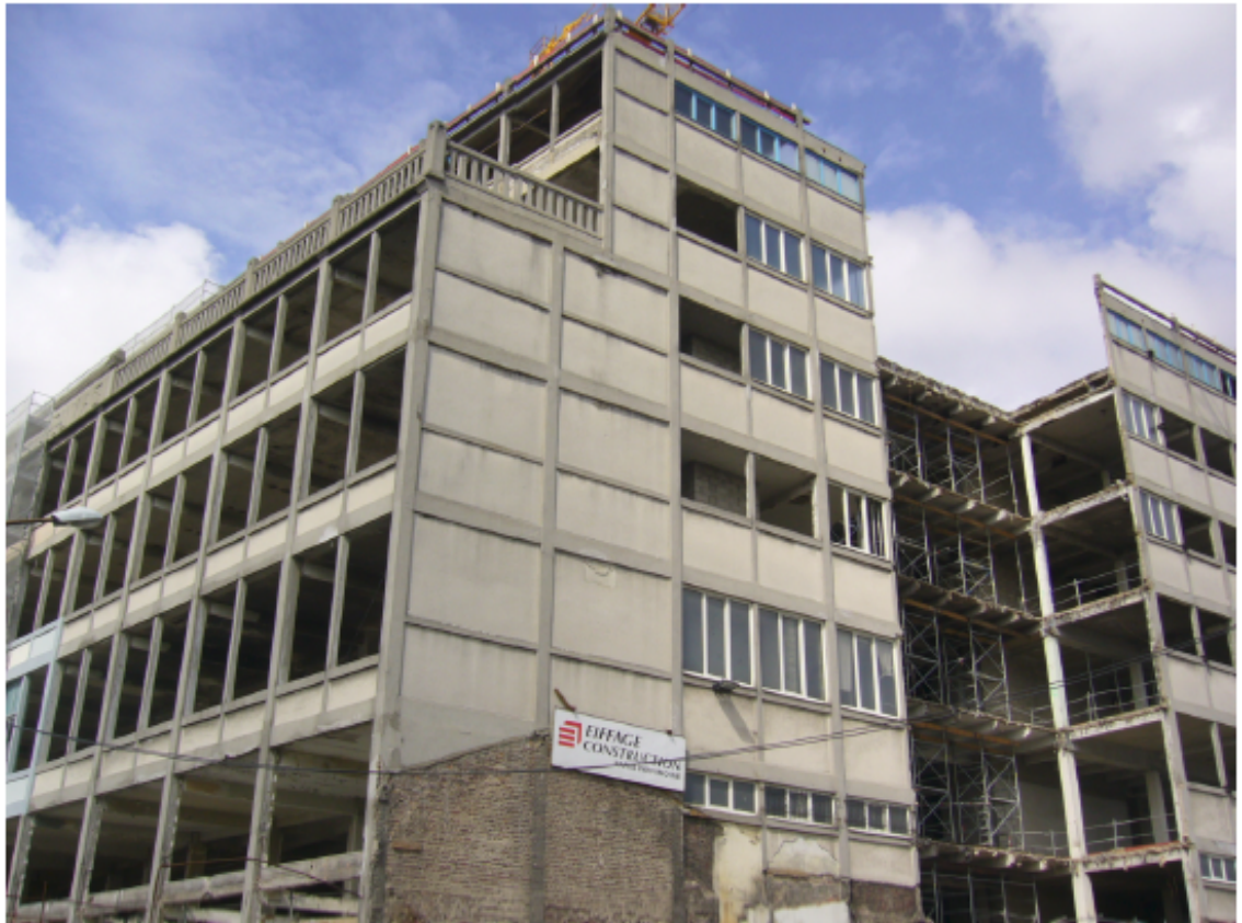
Figure 5-4 : L'ancienne usine Dumas, devenue CAP 1, en travaux pour accueillir le siège de Groupama (mai 2008)
